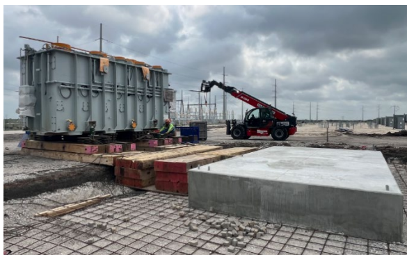
主変圧器の据付
