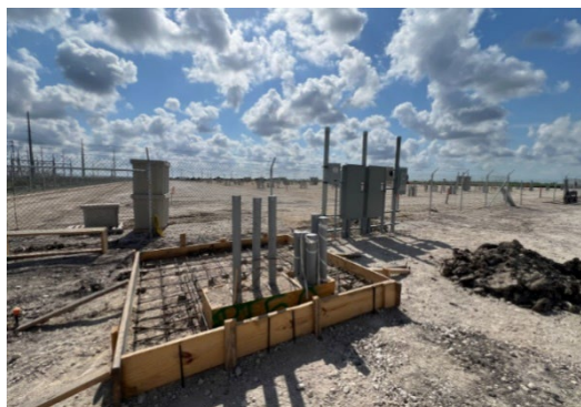
補助変圧器用基礎工事
