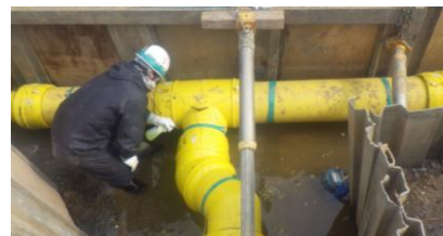
耐震性に優れたポリエチレン管への入替
