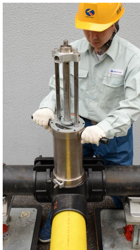
継手(下)に専用の穿孔機を取り付けた状態
