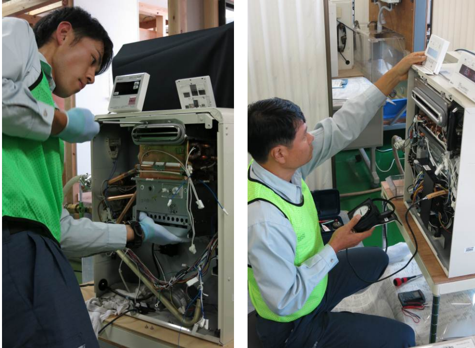
給湯器の「分解技能」(左)とふろ給湯器の「故障診断」競技に臨むサービスショップ作業員
