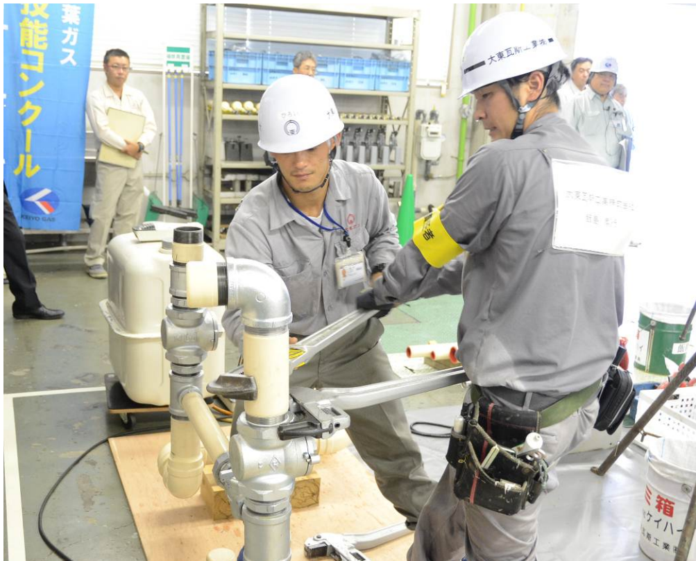
ガスメーター回りの配管を組む作業員＝7月30日、京葉ガス研修センター
