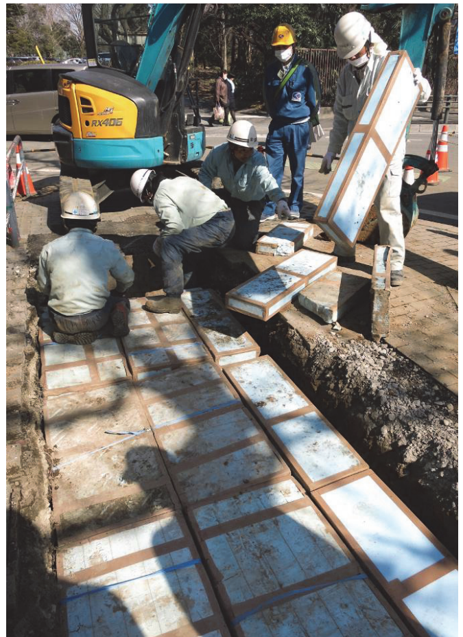
掘削坑に隙間なく敷き詰められた発泡スチロールブロック
