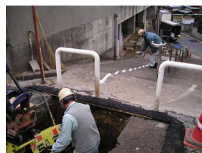
非開削工法の施工状況
