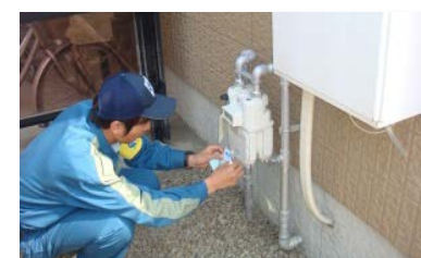
被災地での開栓作業
