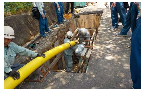
非開削工法の施工状況
