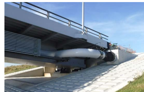
第二中央幹線（妙典橋）
