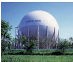
球体の部分は何枚もの高張力鋼をつなぎあわせてつくられています。また、支持地盤まで打ち込んだ杭や強固な鉄筋コンクリート基礎などにより、高い耐震性を確保しています。
