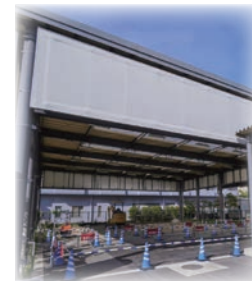
【緊急保安研修センター】(屋外実習場)
